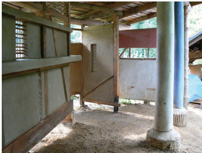
2010 experimenty s jilem — použité materiály na zeď základní vrstva — vrbové proutí, jíl, sláma, voda střední vrstva — tzv. Juraku — jíl, písek, vápno, tráva, bezinky, voda
