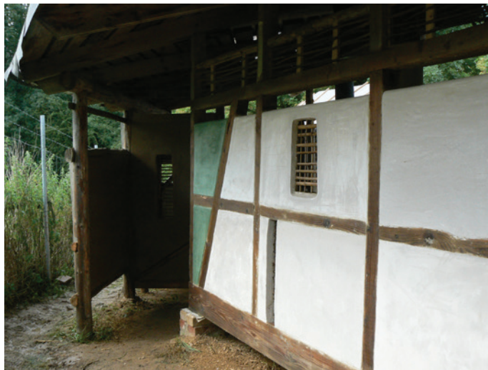
2010 experimenty s jilem — použité materiály na zeď základní vrstva — vrbové proutí, jíl, sláma, voda střední vrstva — tzv. Nakanuri — jíl, písek, sláma, voda horní vrstva — vápno, mramorový prášek, konopí, barevný pigment
